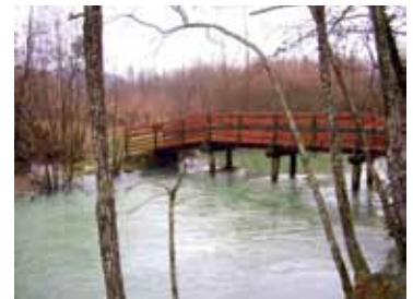
30 / Il ponte di legno sulla Livenza di fronte al santuario della Trinità alla Santissima.
